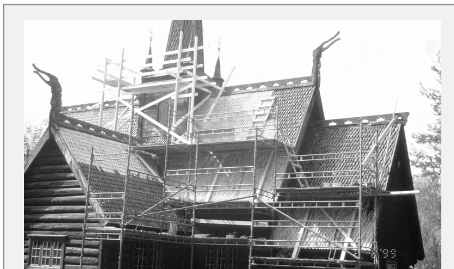
TJÆREBREING AV TAK: På Garmo stavkirke, som står på Maihaugen på Lillehammer, ble det nyttekkede spontaket tjærebredd i 1999.
